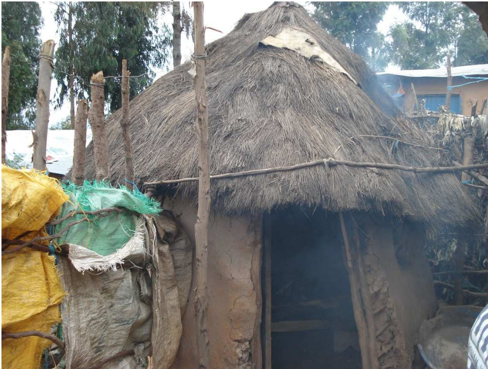
Abb. 6 Übersichtsaufnahme einer typischen Kochhütte Eine Typische Kochhütte aus einem Gerüst aus Hölzern und einem Zweiggeflecht welches mit einer Masse aus Lehm und getrockneten Gräsern verputzt wurde. Das Dach wird mit langen getrockneten Gräsern gedeckt. Rauchschwaden sind omnipräsent.
