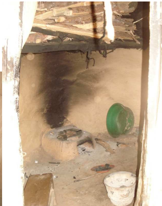
Abb. 5 Typische Kochhütte im Kiziba Refugee Camp: Eine Studienteilnehmerin zeigt ihre Kochhütte mit traditioneller Feuerstelle (a). Einzige Belüftung ist die Tür, ein gerichteter Rauchabzug fehlt. In der Nahaufnahme der Feuerstelle (b) wird die durch die Bauweise bedingte insuffiziente Belüftung des Feuers deutlich.
