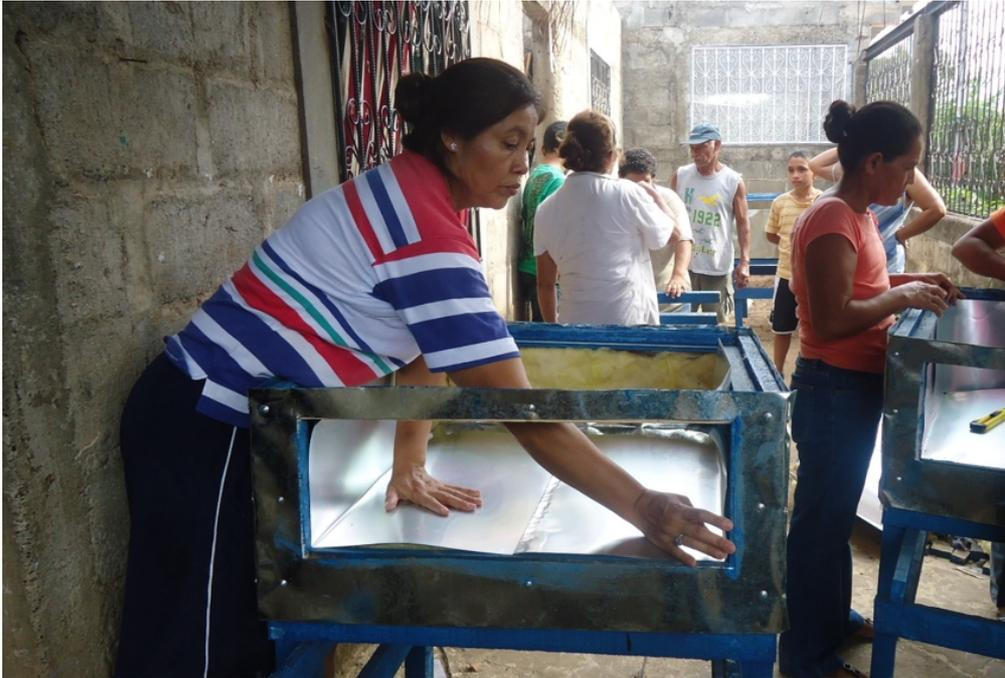
Abbildung 7. Eigenbau der Solaröfen unter Anleitung von NGO- Mitarbeiterinnen.
